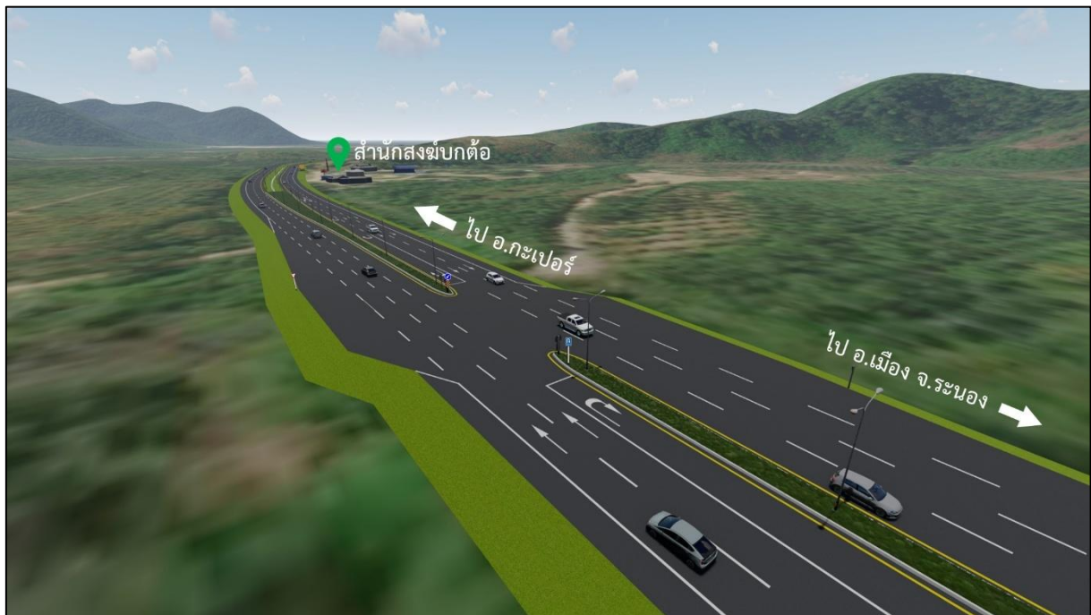
จุดกลับรณะระดับดินแบบเปิดเกาะกลาง กม.กม.615+800
