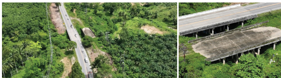
สะพานข้ามห้วยบอน (กม.616+896)
